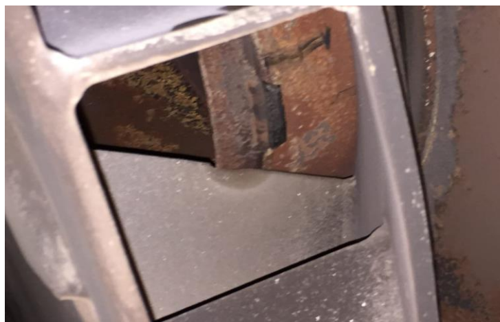
Figura 3: Eixo arriado e empurrando a estrutura
