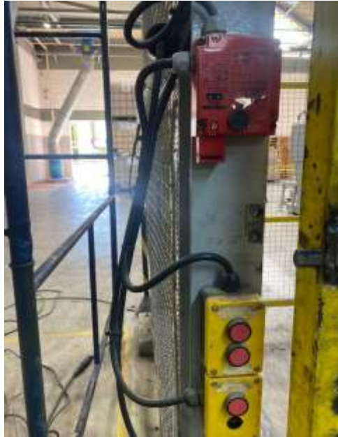
Figura 4 – Sensor de movimento e botoeira de emergência porta de trás.
