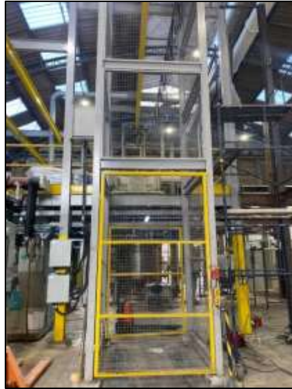
Figura 2- Túnel de carga
