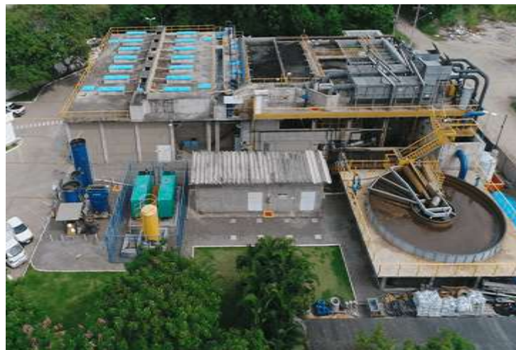
Figura 1: Estação de tratamento: (BRC) Bio reator combinado
