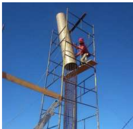
Figura 2: Tubos de papelão sendo usadas para a moldagem de um pilar
