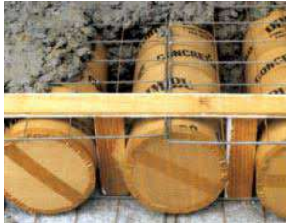
Figura 3: Tubos de papelão sendo usado para caixão perdido
